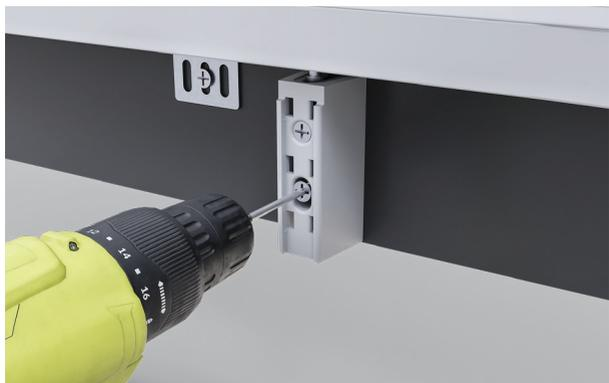
2. Insérez le diviseur de débit sur la vis à la base de la porte. Fixez à l'aide des vis fournies.
