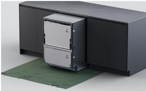
**2.** Enfoncez soigneusement le produit dans la cavité, en faisant passer les tuyaux à travers les trous de service au fur et à mesure.
