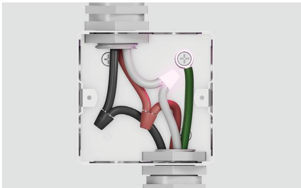
5. Separe los cables del horno verde y blanco precintados de fábrica. Si la caja de conexiones está conectada a tierra, conecte el cable verde a la caja de conexiones metálica con un tornillo antes de conectar el cable blanco del horno al cable neutro (blanco) de la caja de conexiones.
