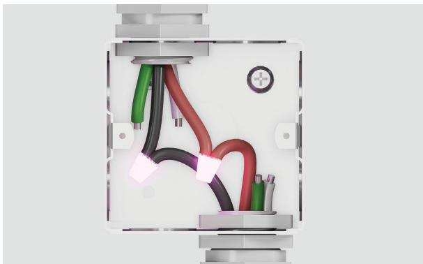
3. Connectez les deux fils noirs ensemble avec des connecteurs à visser et les deux fils rouges ensemble avec des connecteurs à visser.
