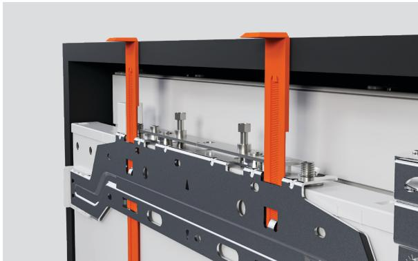
**4.** Eleve el medidor de altura hasta la parte superior del gabinete. Alinee con la base del panel superior si está instalado, o con la base del panel de la puerta si no hay panel superior.
